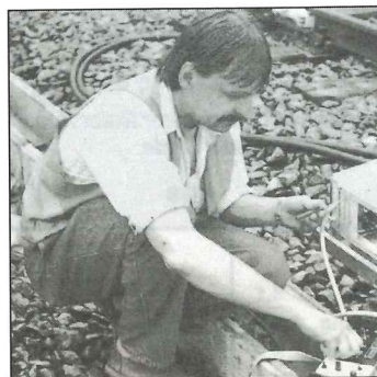
Siemens Außenmonteur im Einsatz
