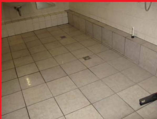
Duschen in der Außenstelle Kralenriede
